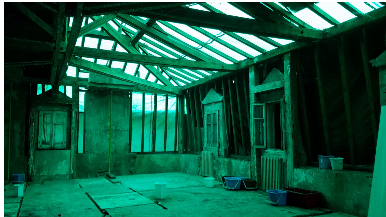
Charpente en reconstruction. Photo Alexandre Mulot
