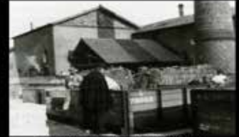
JEAN-BAPTISTE PERRUSSON (DE DOS) À L'USINE VERS 1900
