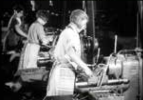
DE L'ATELIER À L'USINE !
