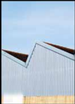
SUR LE TOIT
